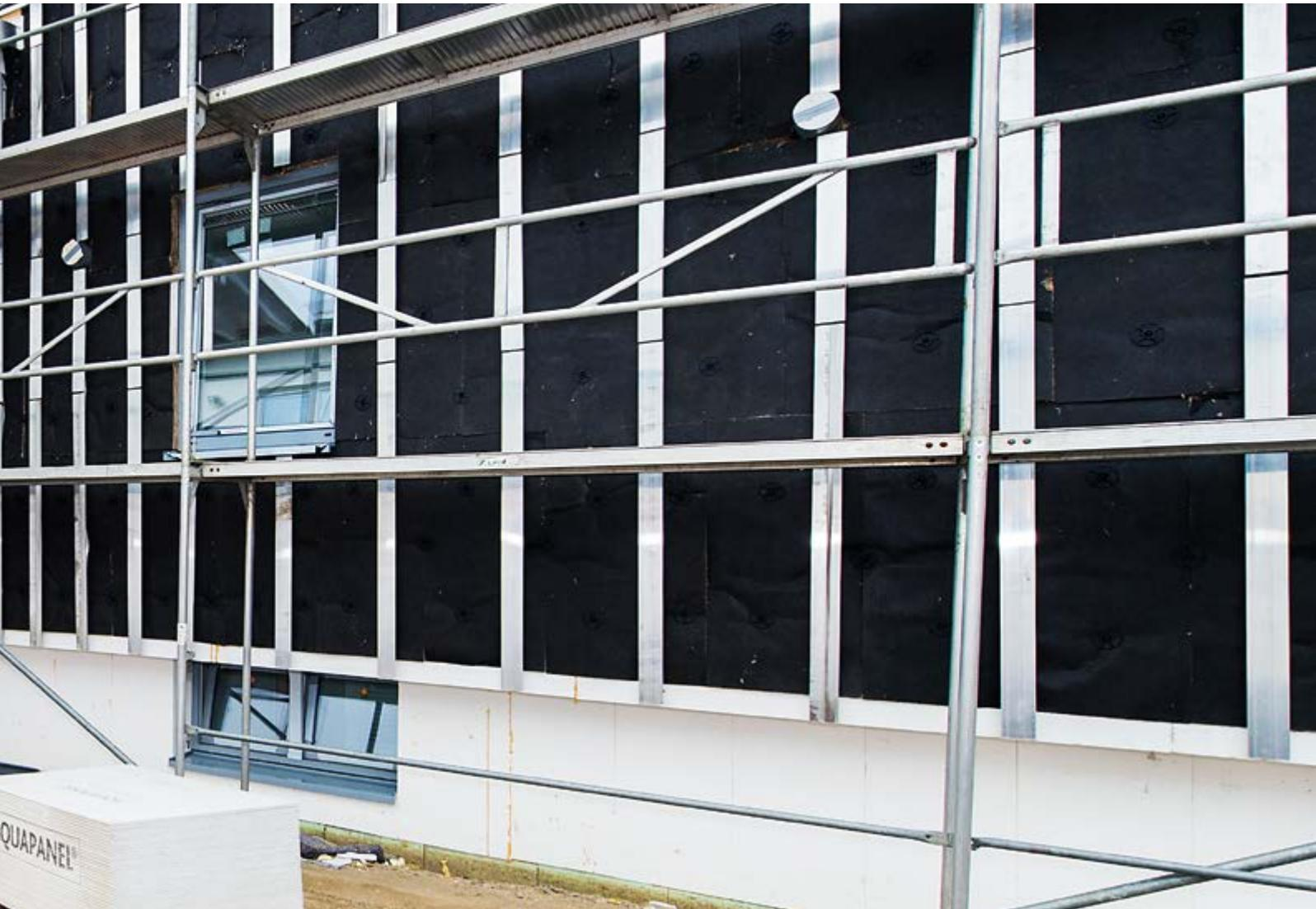
einer VHF wird im Brandfall wesentlich schlechter, wenn die Dämmplatten nicht vollflächig auf der Massivwandoberfläche aufliegen. In dem hier nicht gewollten Luftspalt kann es zu einem Übergreifen des Feuers auf andere Teile des Bauwerks oder andere Geschosse kommen.
