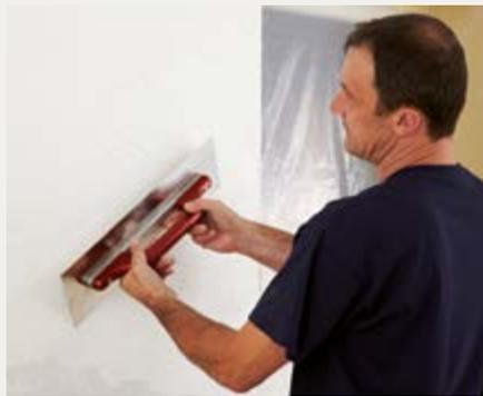
**Pastöse Oberputze** sind verarbeitungsfertig eingestellt. Der Eimerinhalt ist lediglich aufzurühren und bei Bedarf mit maximal 0,7 Liter Wasser auf Verarbeitungskonsistenz einzustellen. Sie sind nur auf vollständig ausgetrocknete, erhärtete und vorbehandelte Unterputze und Armiermörtellagen aufzutragen. Eine Vorbehandlung des Untergrundes ist für das Erreichen einer optimalen Produktqualität notwendig und für die Verarbeitung dringend zu empfehlen.
