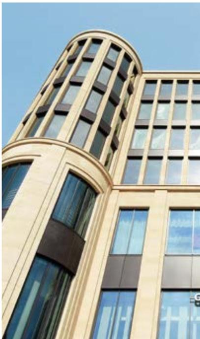
Die vorgehängte hinterlüftete Fassade (VHF) ist nicht umsonst eines der Erfolgsmodelle der zeitgemäßen Fassadentechnik. In ihr fließen gleich mehrere wesentliche Anforderungen an moderne Gebäude zusammen – egal, ob es sich um einen Neubau oder eine Sanierung handelt.
