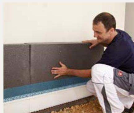
Sockel-Abschlussprofil waagrecht montieren und mit Nageldübeln im Abstand von ca. 300 mm befestigen. Untergrundtoleranzen mit Unterlegscheiben ausgleichen. Stöße der Sockel-Abschlussprofile mit H-Verbindern zusammenstecken.
