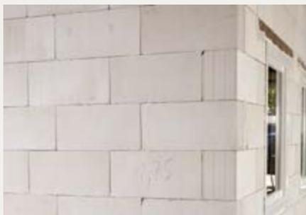
Bei neuwertigen Untergründen ohne Putz, wie Mauerwerk nach DIN 1053 und Beton nach DIN 1045 sowie bei verputzten Untergründen, welche eine Abreißfestigkeit von  $\geq 0,08 \text{ N/mm}^2$  aufweisen, kann in Abhängigkeit der jeweiligen Systemzulassung von einer zusätzlichen Verdübelung des Dämmmaterials abgesehen werden.
