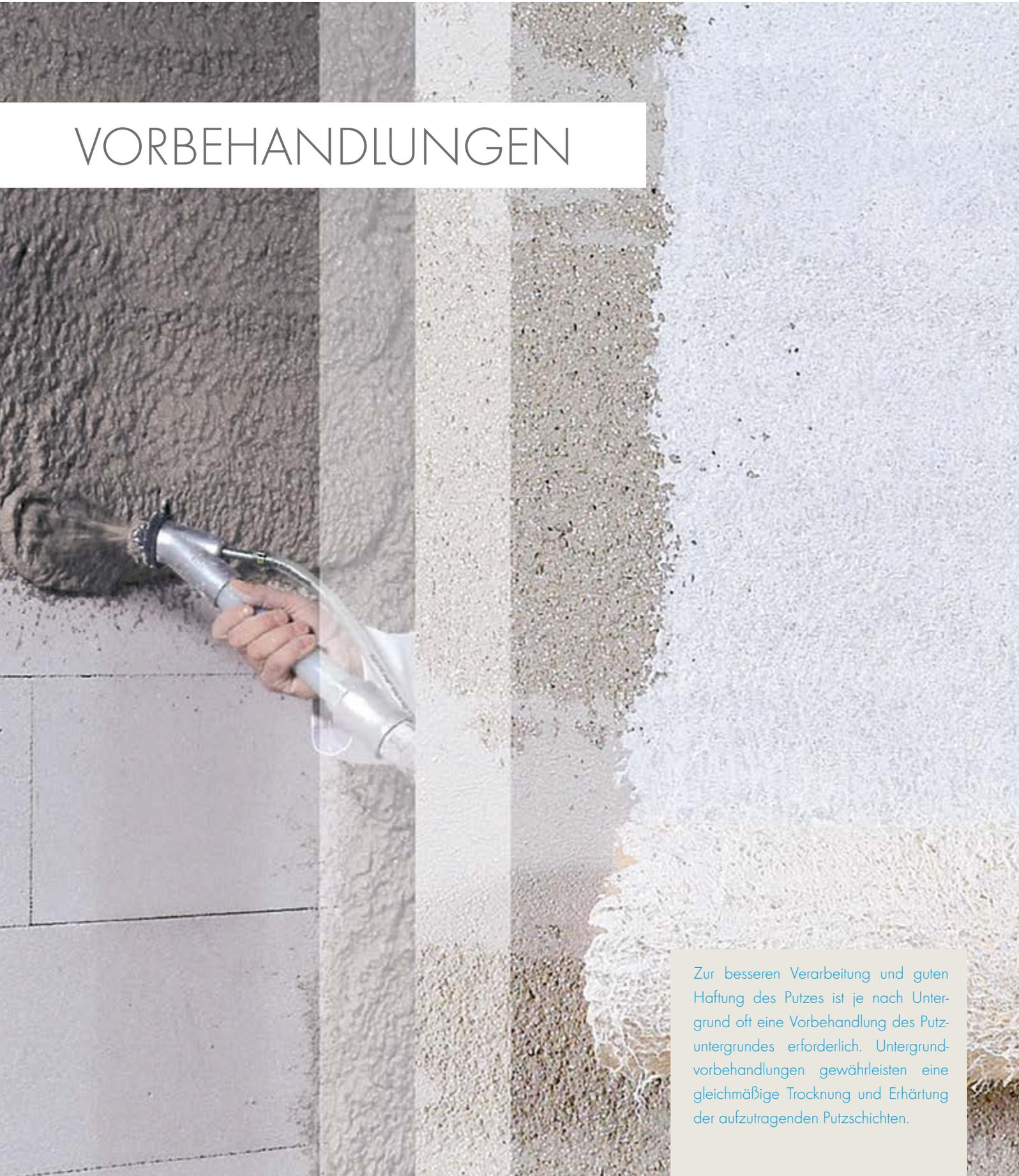
Zur besseren Verarbeitung und guten Haftung des Putzes ist je nach Untergrund oft eine Vorbehandlung des Putzuntergrundes erforderlich. Untergrundvorbehandlungen gewährleisten eine gleichmäßige Trocknung und Erhärtung der aufzutragenden Putzschichten.
