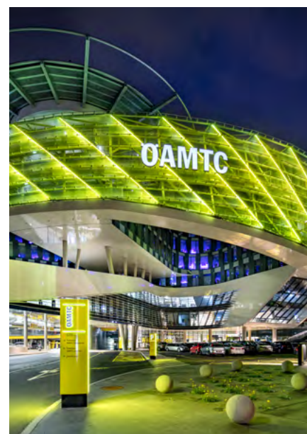
ÖAMTC Zentrale, Wien Architekt: Christoph Pichler und Johann Traupmann
