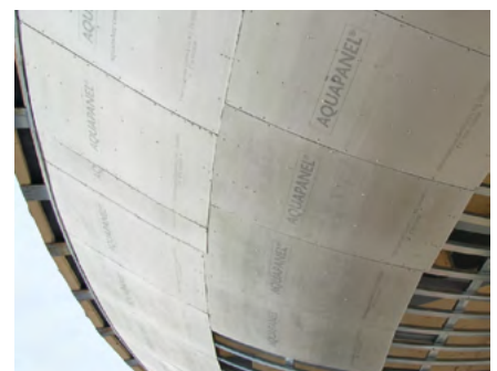
Blick auf die Unterkonstruktion
