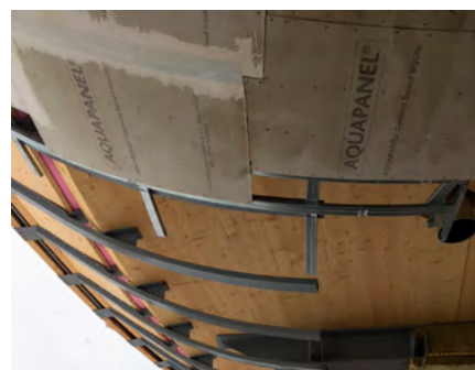
Blick auf die Unterkonstruktion
