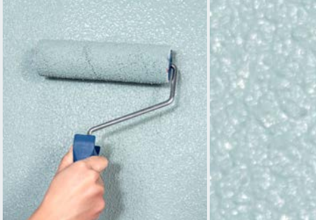
EASYPUTZ 0,5 mm strukturiert mit Finishwalze (rechts in Originalgröße)
