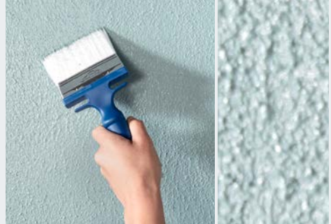
EASYPUTZ 1 mm strukturiert mit Finishpinsel (rechts in Originalgröße)
