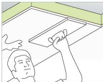
Der Kleber ist vollflächig auf die Plattenrückseite aufzubringen und abzukämmen. Die Größe des Zahnsachtels sowie die Klebermenge sind abhängig von der gewählten Plattendicke. Durch die Haftbeschichtung ist auch ein maschineller Klebemörtelauftrag möglich. Der unmittelbare Plattenrand (ca. 1 cm) sollte frei von Kleber bleiben, damit beim Anbringen der Platte kein Kleber in die Plattenstöße gedrückt wird.
