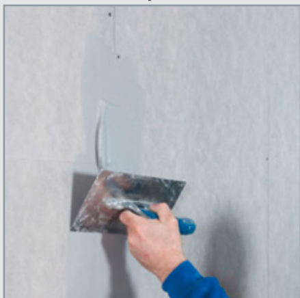
Krok 1: Vypĺňte spáru systémovým tmelem Drystar-Filler
