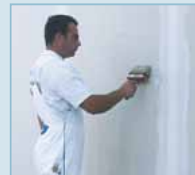
Το αστάρωμα γίνεται με βούρτσα ή ρολλό
