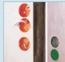
Τοποθετημένα κουτιά ηλεκτρικών εγκαταστάσεων
