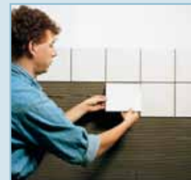
Επικόλληση πλακιδίων με ελαστική κόλλα
