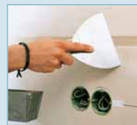
Στοκάρισμα της γυψοσανίδας
