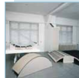
Καμπύλωση γυψοσανίδας σε φόρμα
