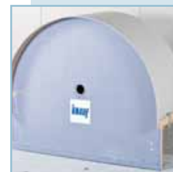
Καμπύλωση γυψοσανίδας σε φόρμα
