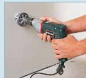
Άνοιγμα εγκοπών για κουτιά ηλεκτρικών εγκαταστάσεων
