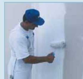
Επάλειψη χρώματος με ρολλό
