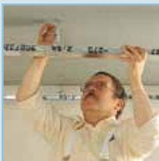
Τοποθέτηση ανάρτησης
