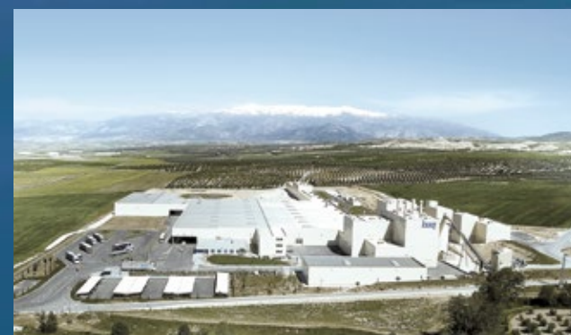
CENTRO DE PRODUÇÃO (placas de gesso laminado, perfis, pastas) EM ESCÚZAR (Granada), que iniciou a sua atividade em março de 2008.
