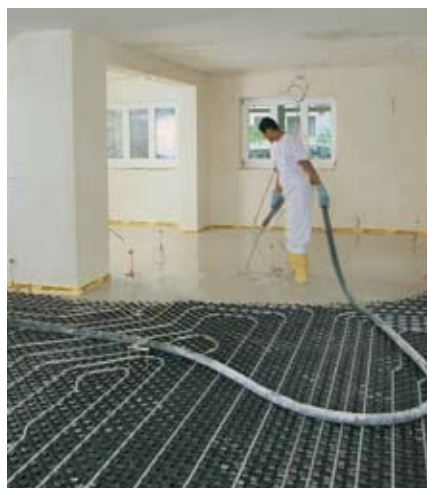
Pašizlīdzinošā grīdas seguma ieklāšana virs apsildāmās grīdas
