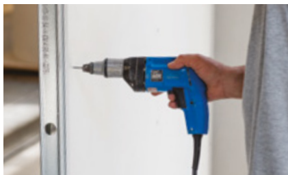
Vissage des plaques Knauf HydroProof®
