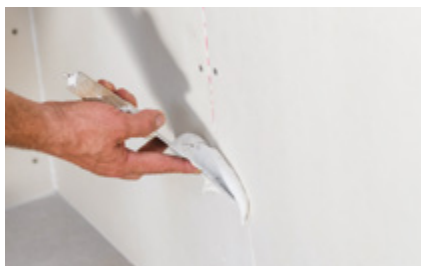
Enduisage et mise en place de la bande à joint Knauf HydroProof® avec l'enduit prêt à l'emploi Knauf Proplak® HydroProof® : facile à mettre en œuvre, pour un rendu très blanc et une finition parfaite.
