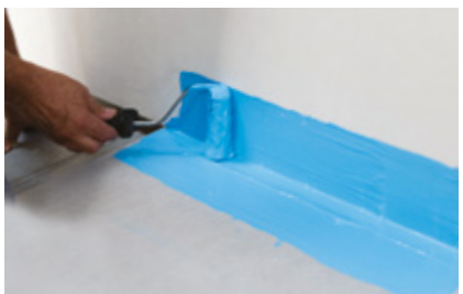
Protection des pieds de cloison avec le SPEC Knauf Étanche : Application d'une 1 ère couche de produit dilué. Après séchage, application d'une 2 ème couche de Knauf Étanche non dilué et mise en œuvre de la bande Knauf Étanche. Puis, application d'une dernière couche de Knauf Étanche non dilué.
