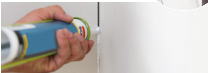
Traitement des angles et points singuliers à l'aide d'un mastic sanitaire label SNJF
