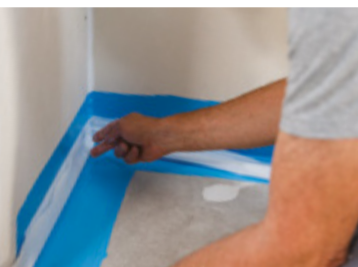
Protection des pieds de cloison avec le SPEC Knauf Étanche : Application d'une 1 ère couche de produit dilué. Après séchage, application d'une 2 ème couche de Knauf Étanche non dilué et mise en œuvre de la bande Knauf Étanche. Puis, application d'une dernière couche de Knauf Étanche non dilué.
