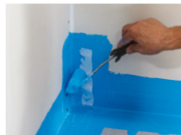
Protection des pieds de cloison avec le SPEC Knauf Étanche : Application d'une 1 ère couche de produit dilué. Après séchage, application d'une 2 ème couche de Knauf Étanche non dilué et mise en œuvre de la bande Knauf Étanche. Puis, application d'une dernière couche de Knauf Étanche non dilué.
