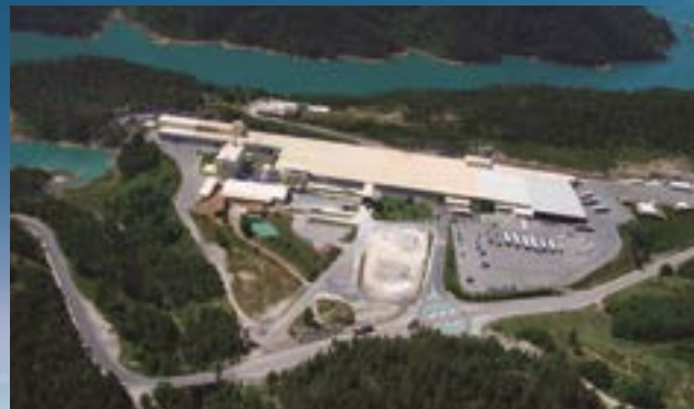
CENTRO DE PRODUCCIÓN (placa de yeso laminado y perfiles) EN GUIXERS (Llérida), que inició su actividad en febrero de 1991.
