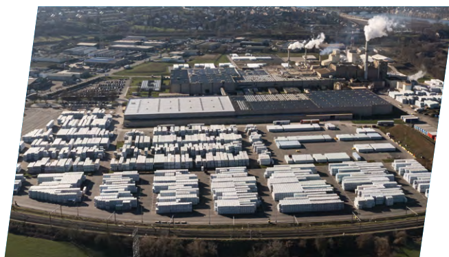
Belgiyaning Vize shahridagi, Knauf Insulation bosh qarorgohi va ishlab chiqarish maydonchasi
