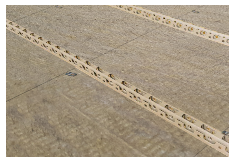
Drunterleisten auf Tektalan Platten (Drunterleisten so verlegen, dass die offenen Kanten zur Bewehrung zeigen)
