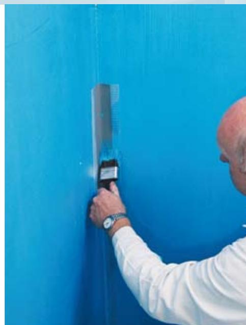
*Emulsion de bitume Knauf et bande d'étanchéité Knauf*
