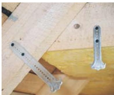
Fixation de l'ossature : suspension en forme d'ancre Knauf 90 mm ou 200 mm.
