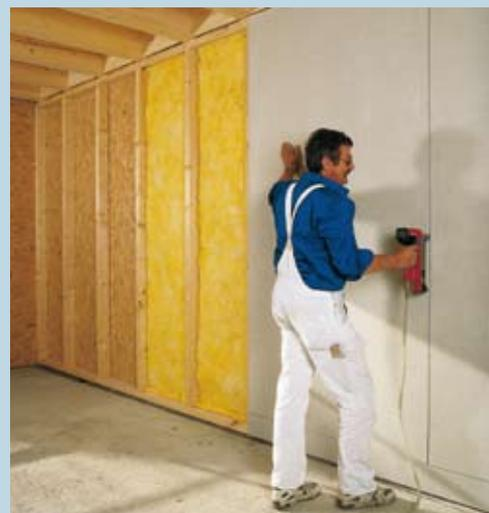
Les plaques Vidiwall sont disponibles avec différents types de chants. L'exécution des chants détermine la technique de jointoiment.
