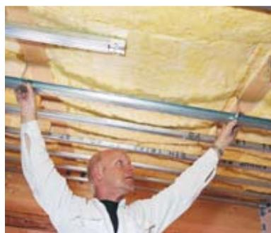
Insertion des profilés CD Knauf dans les suspensions en forme d'ancre.
