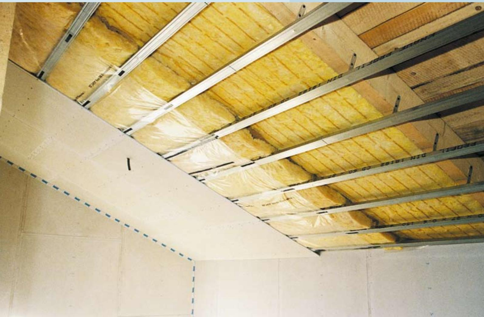
Montage correct du revêtement de combles avec des plaques en fibroplâtre Vidiwall VT.
