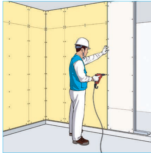
1 바탕 및 마감 석고보드(아쿠아락 E) 시공
