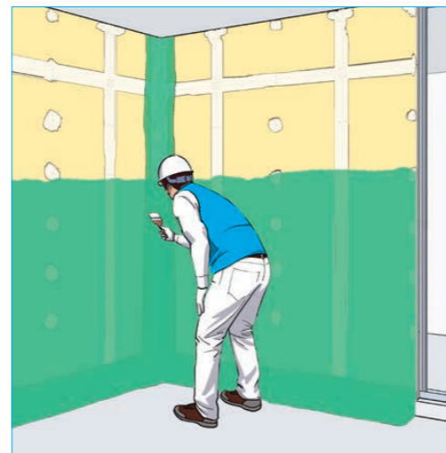
4 도막 방수재 시공
