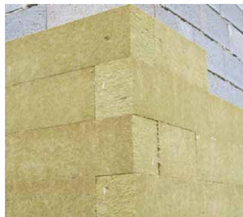
Slika lepljenja fasadne lamele FKL
