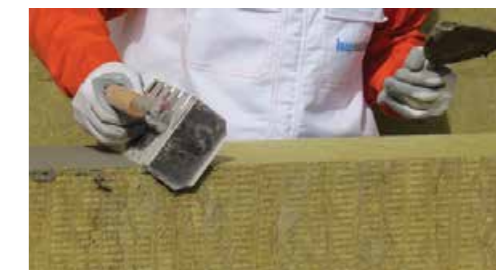
Slika nanosa lepila na fasadni lameli FKL
