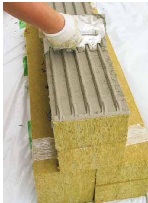
Slika lepljenja fasadne lamele FKL
