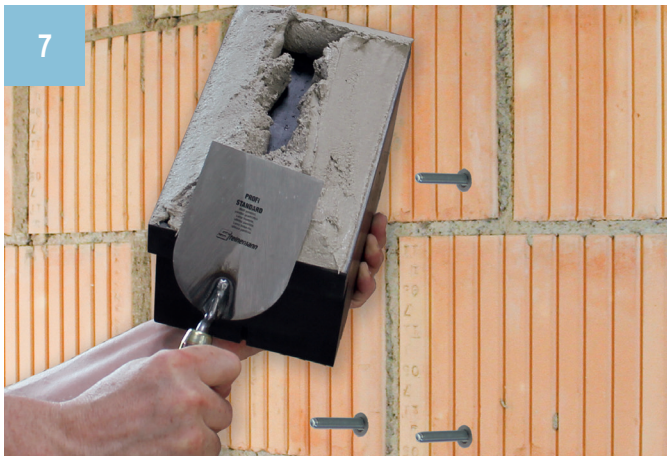
Het universele montageblok volvlakig op de ondergrond verkleven met een kleefmortel zoals Knauf SupraCem of SupraCem PRO. Verbruik per montageblok bij een laagdikte van 5 mm: ca. 0,33 kg.
