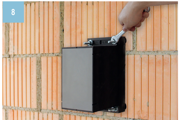
De moeren vastdraaien op het montageblok.
