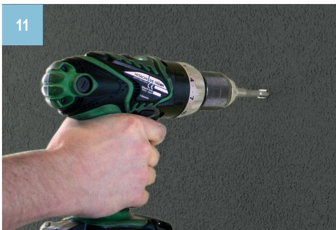
Draadsnijden/draadtappen doorheen de aluminiumplaat en de HPL-plaat.
