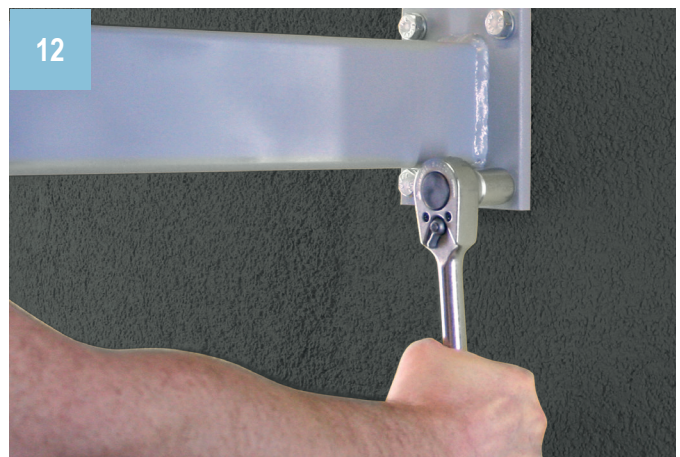
De last op het universele montageblok ALU-TRI vastschroeven. De verankeringsdiepte moet minstens 30 mm bedragen en de schroef moet over de volledige dikte van de aluminiumplaat bevestigd worden. Om de totale verankeringsdiepte te bepalen is het noodzakelijk om de dikte te kennen van het pleistersysteem en van de te monteren element. De voorschriften van de fabrikant in acht nemen wat betreft aandraaimomenten.
