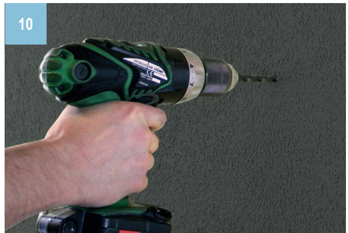
De lasten pas bevestigen als de gevel afgewerkt en uitgedroogd is. De gaten doorheen de aluminiumplaat en de HPL-plaat boren. De diepte van het boorgat moet tussen 35 en 45 mm liggen.
