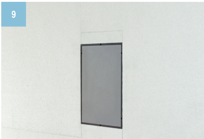
De isolatieplaten aan het universele montageblok laten aansluiten zonder voegen. Vóór de wapeningsmortel wordt aangebracht de exacte positie van het montageblok opmeten of een plaatschroef aanbrengen als markering zodat de aangebrachte montageblokken makkelijk teruggevonden kunnen worden na afwerking van het geveloppervlak.
