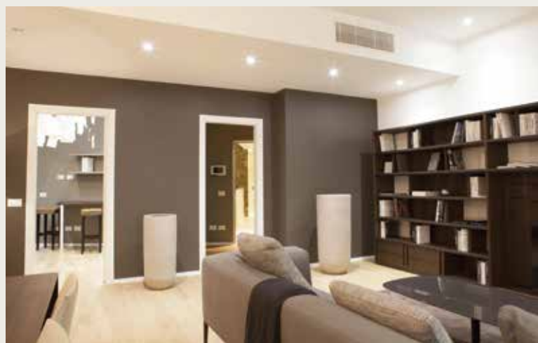
Bytový domo Foro Buonaparte - Priečky a šachtové steny - opláštenie s doskami Vidiwall + GKB
