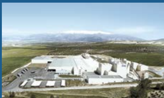
CENTRO DE PRODUCCIÓN (placa de yeso laminado, perfiles, pastas) EN ESCÚZAR (Granada), que comenzó su actividad en marzo de 2008.
