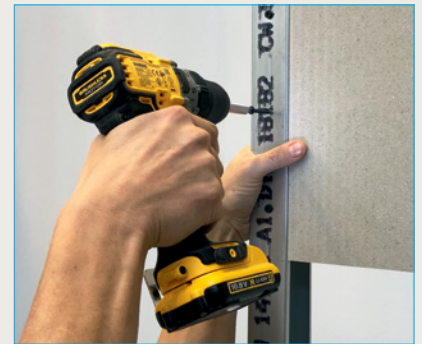
3 Stirnseitige Verschraubung
