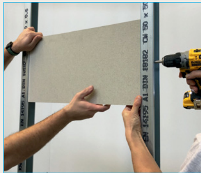
2 Seitliche Verschraubung im CW
