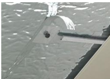
Figure 13 : Mise en œuvre du parement de finition
