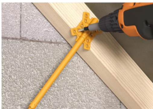
Figure 5 : Vissage des Suspentes RT sur la charpente
