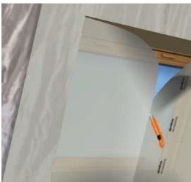
Figure 14 : Mise en œuvre du pare vapeur indépendant
