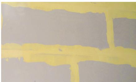
Remplissage des joints à l'aide du Safeboard Spachtel jaune pour une sécurité maximale
