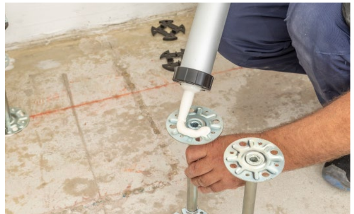
Bild 9: Apply GIFAfloor pedestal adhesive
