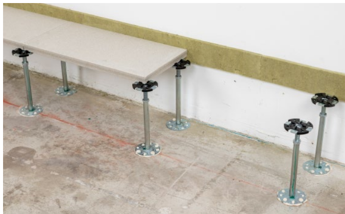
Bild 24: Set up pedestals.
